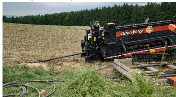
*Bohrung der Wasserleitung für die neuen Bauparzellen durch die Firma Hauer.*
